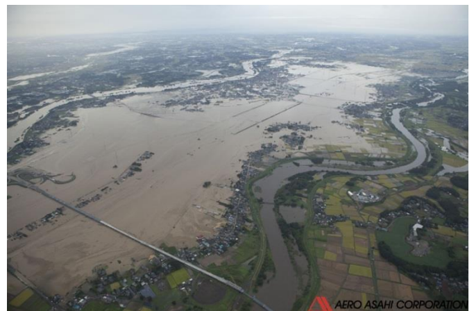
常総市石下下流左岸 氾濫状況
