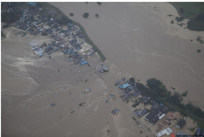
決壊地点周辺の状況
